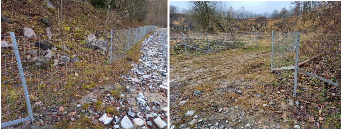
Clôtures posées en novembre
